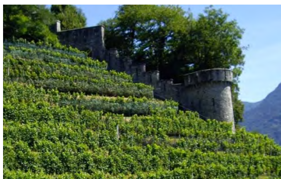
Vigneti terrazzati a Sementina con muro medioevale ( www.pizzorin.ch ).
